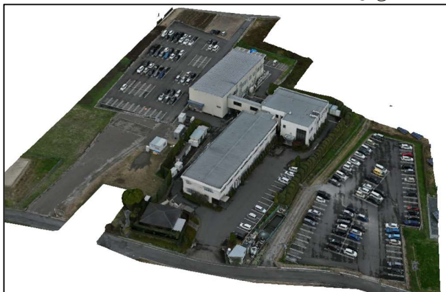
空中写真より生成した弊社敷地の3Dモデル 使用機種 DJI Mavic 3 Enterprise
