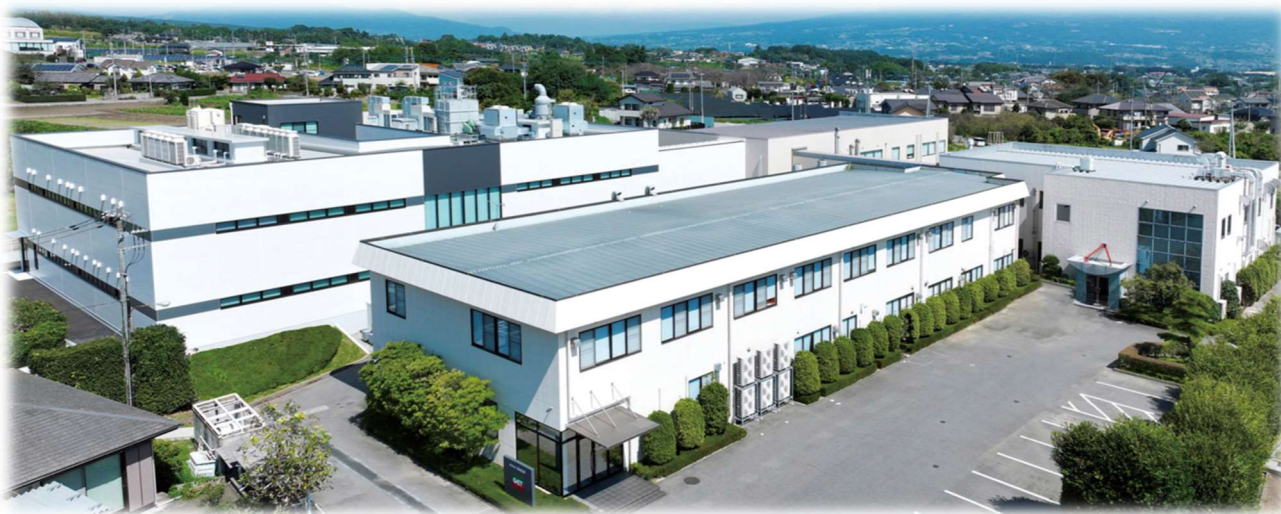
環境技研 全景/4号棟(左奥)
