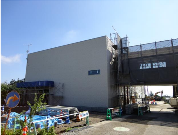
建設中の医薬分析棟
