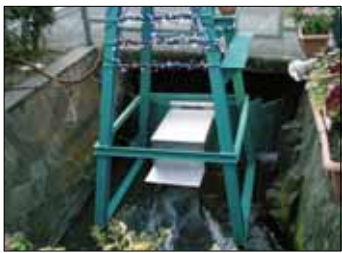
馬場川での小水力発電実証実験
