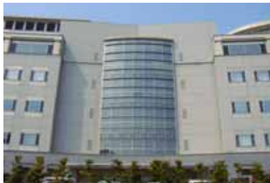
太陽電池が入った窓ガラス(太田市役所)
